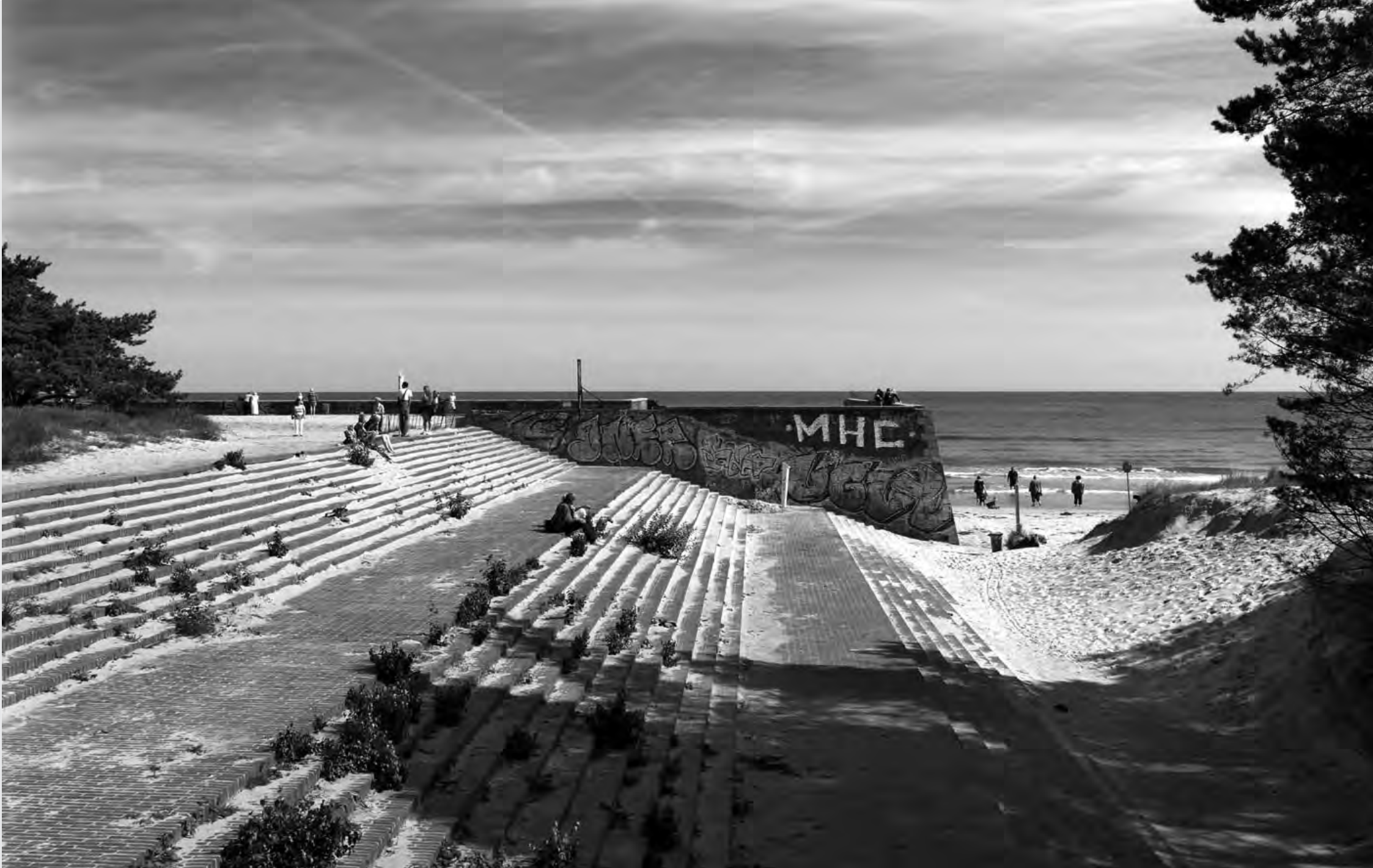
Insel Rügen, Prora: Dieses Werk sollte nach dem „Endsieg“ als Seebrücke dienen. Es war geplant, dass an zwei in die Ostsee ragende Fingerpiers Passagierschiffe festmachen können, wohl auch die Wilhelm Gustloff. Auf Wunsch des „GröFaZ“ wurde das KdF-Bad auch als Lazarett für einen bevorstehenden Krieg konzipiert.
